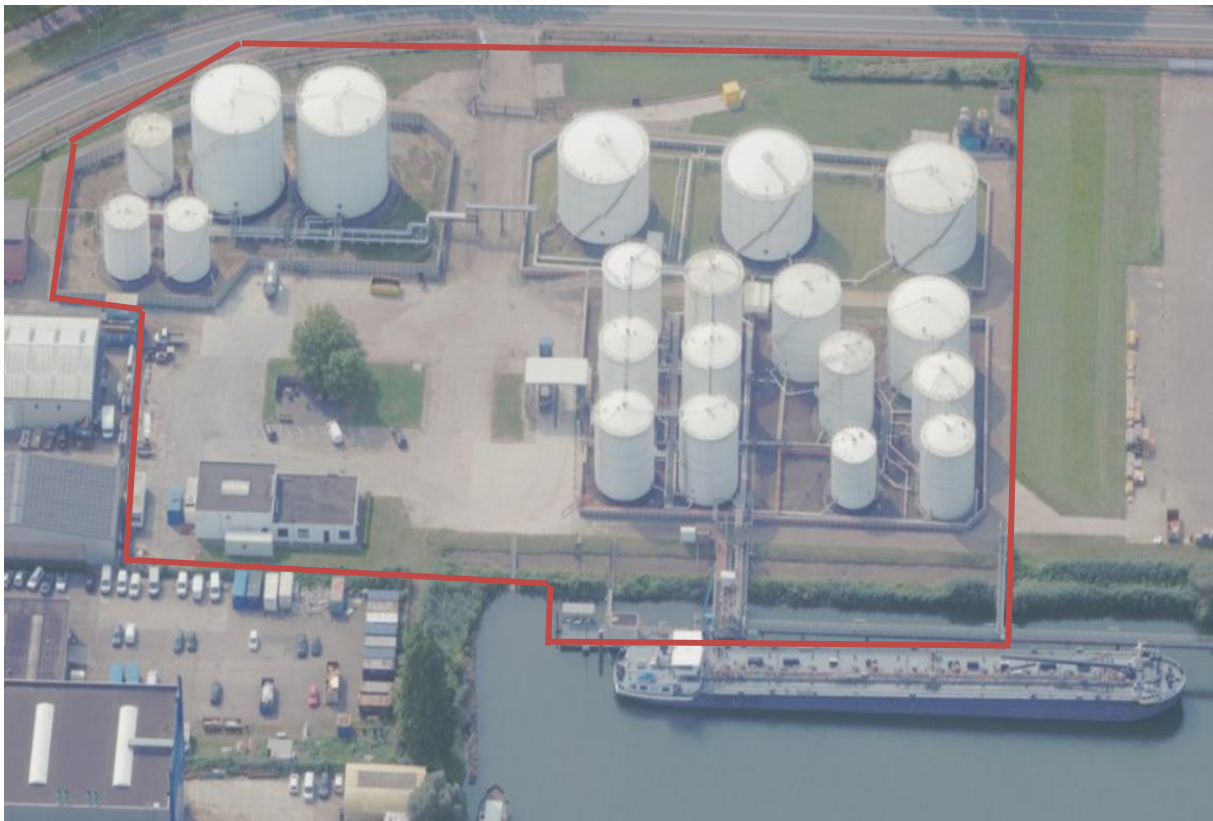
Figuur 2.1.1; Overzicht terrein Standic Oil Storage B.V.
